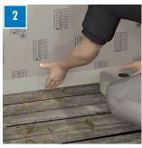
Nach der Vorbereitung des Untergrunds Randdämmstreifen umlaufend an alle Wand-/Bodenanschlüsse anbringen.
