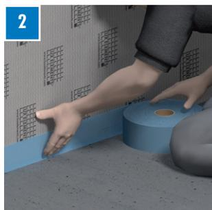
Nach der Vorbereitung des Untergrunds Randdämmstreifen umlaufend an alle Wand-/Bodenanschlüsse anbringen.
