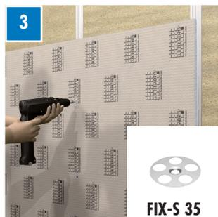
... und mit FIX-S 35 + geeigneter Schraube verschraubt.
