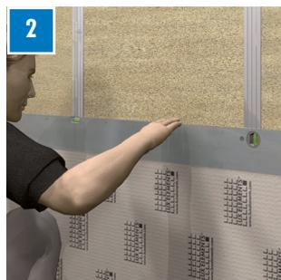
Das erste ELEMENT-EL wird quer zu den Profilen lot- und fluchtrecht ausgerichtet ...
